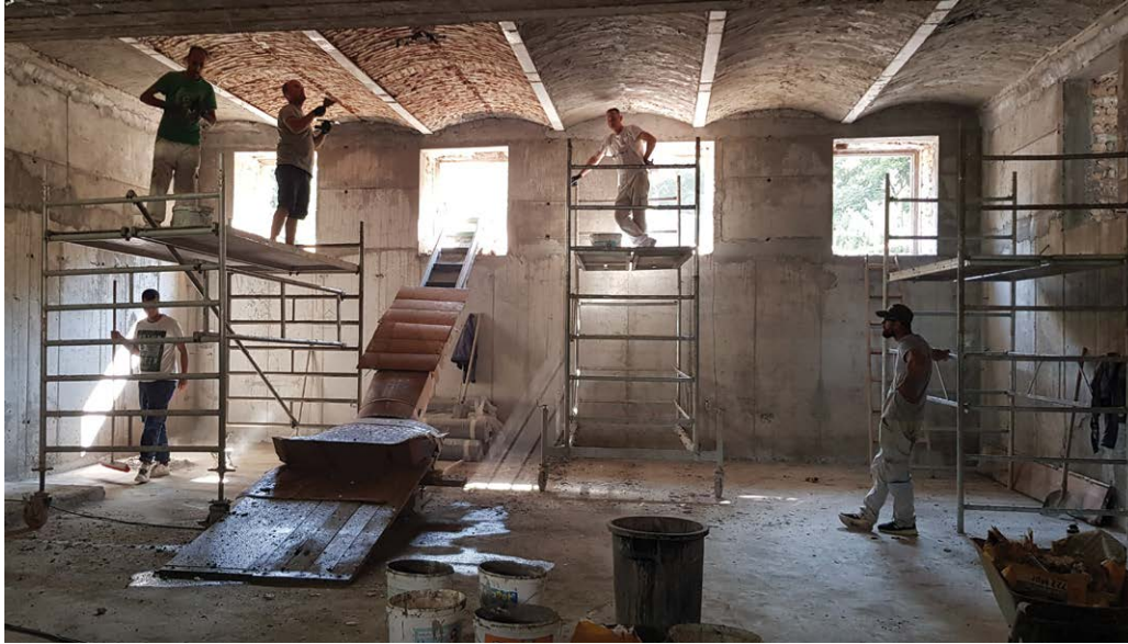
Obnova zgrade Osnovne škole dr. Ivana Merza u Zagrebu
